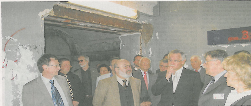
Keine Angst vor der maroden Unterführung: Innenminister Karl Peter Bruch (Vierter von rechts) nimmt den Bahnhof in Jünkerath in Augenschein. TV-Foto: Christian Brunker
