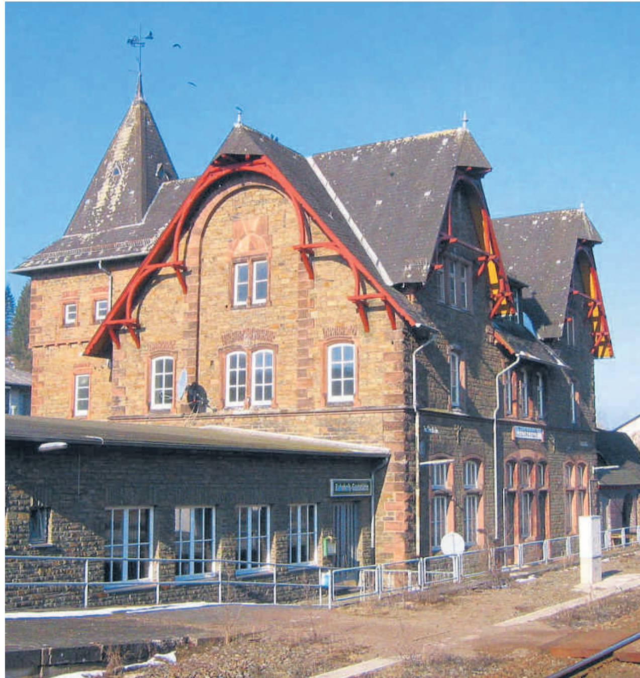
Für fünf Millionen Euro soll der Bahnhof Jünkerath auf einen zeitgemäßen Stand gebracht werden.
